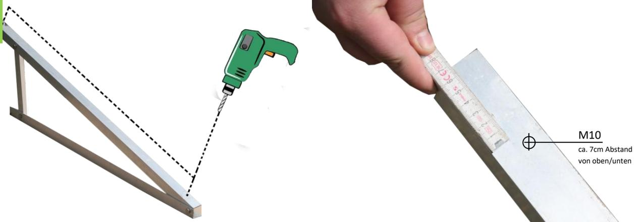
Bohren Sie mittig mit einem geeigneten Bohrer oben und unten ein Loch in die **Aufständerdreiecke (A)** für eine **M10 Schraube**. Für die meisten Solarmodule und Ausrichtung eignet sich ein Abstand von ca. 7cm.
